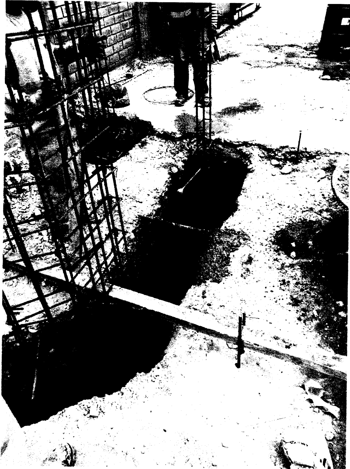
TRABAJOS DE ACERO EN COLUMNAS
