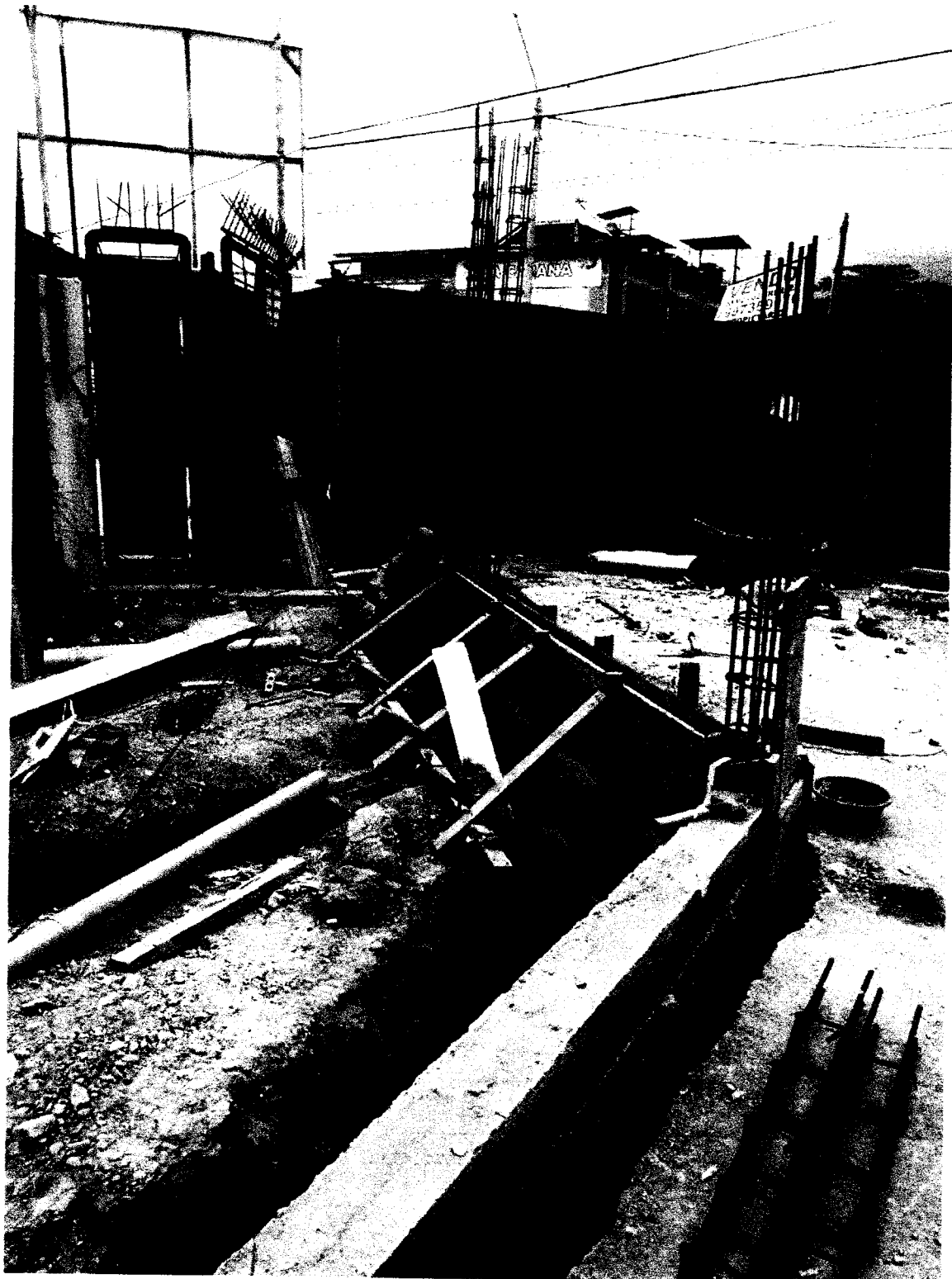
TRABAJOS DE ENCOFRADO DE SOBRECIMENTOS Y ACERO EN COLUMNAS
