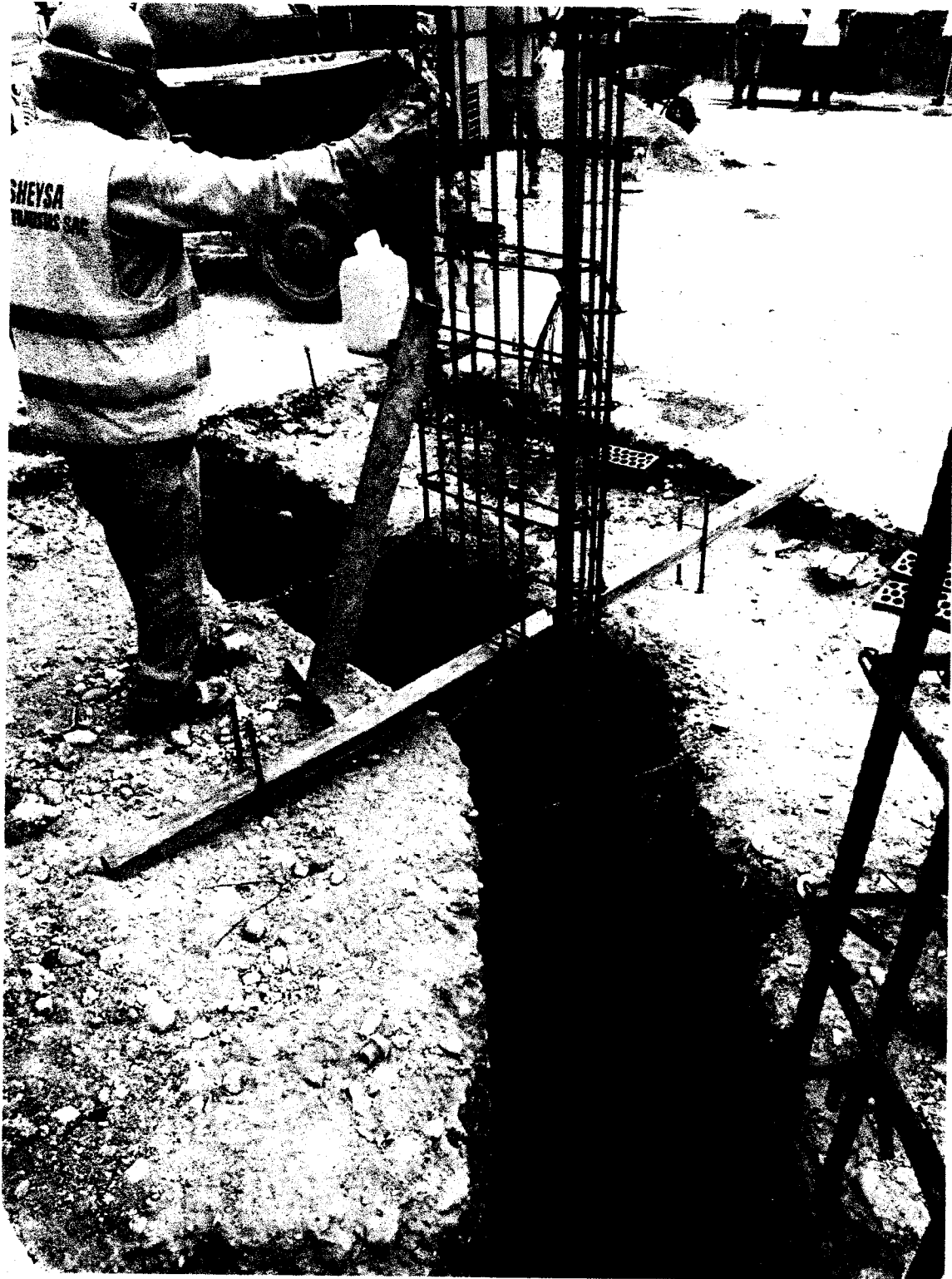
TRABAJOS DE ACERO EN COLUMNAS
